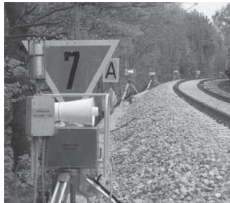
Slika 1. Primjer uređaja za automatsku najavu nailaska voza
