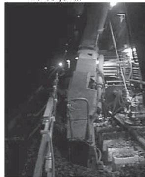
Slika 5. Uređaji za najavu nailaska voza integrirani u zaštitnoj ogradi pored stroja za rešetanje tucaničke zastorne prizme (lijevo) i zaštitna ograda pored radnog voza (desno)
